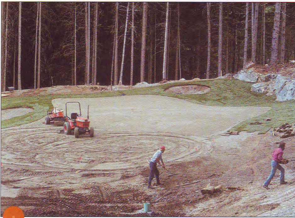
Le placage est un moyen très efficace de lutte contre l'érosion au pourtour des greens.
